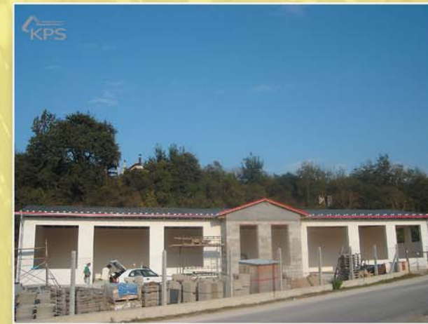
• výrobná hala Hubina
