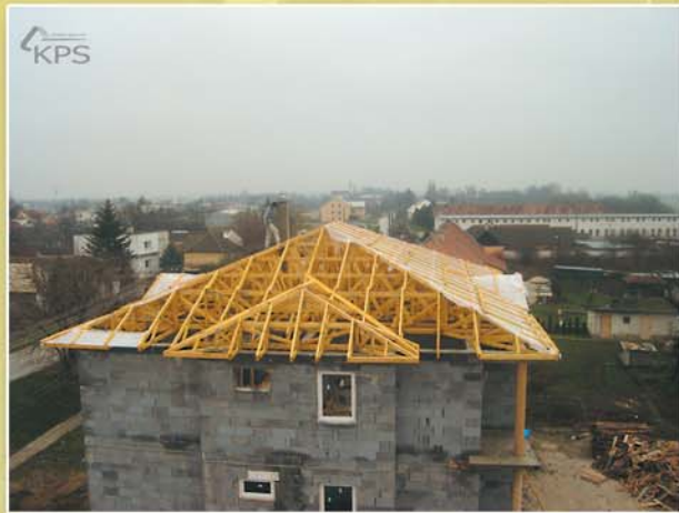
• bytový dom Borovce
